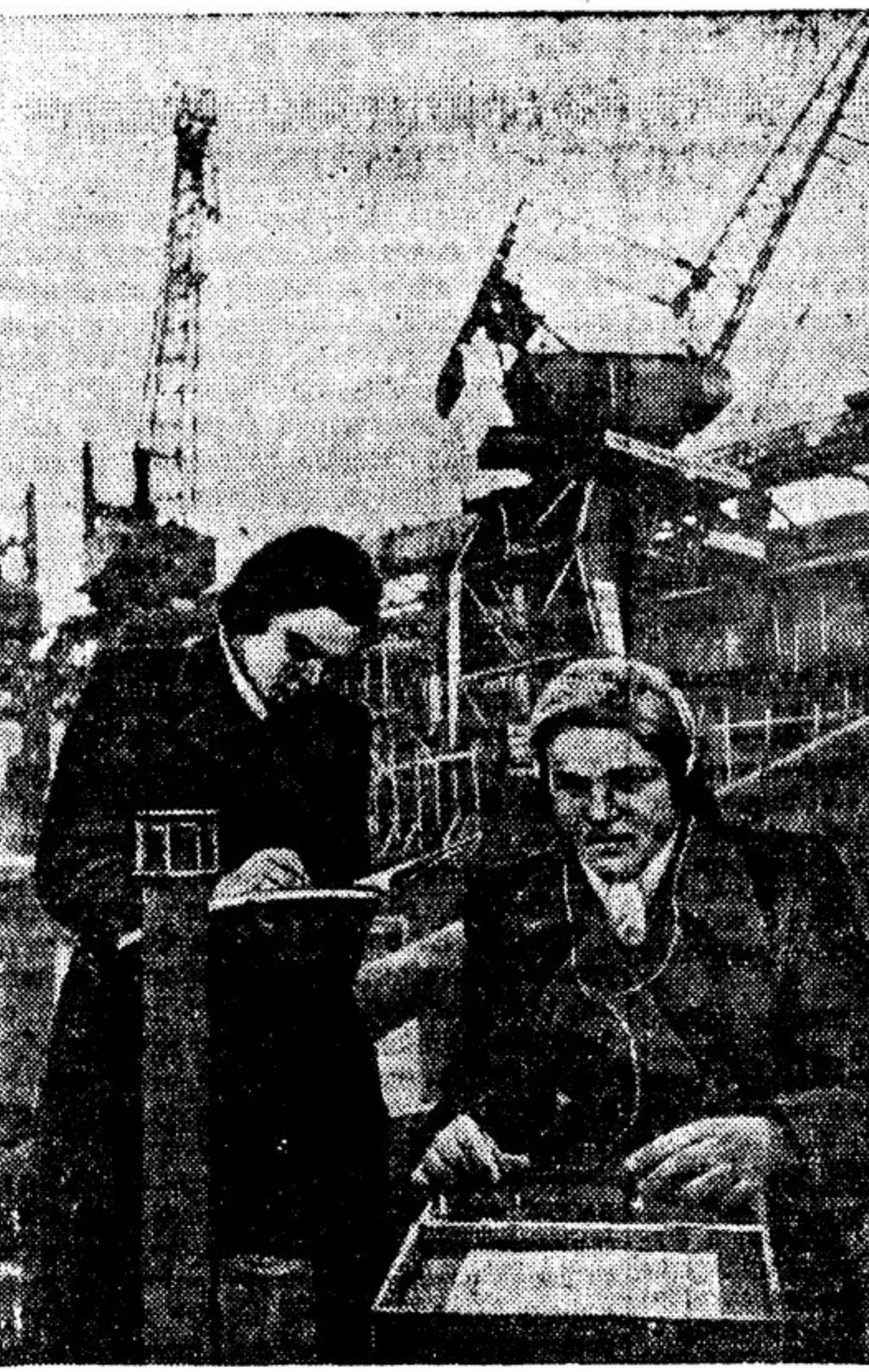
Лаборанты «Гидропроекта» Шура Короткова (слева) и Марус Кожина «прослушивают» железобетонную плотину Цимлянского гидроузла.
